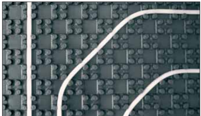
Rohrbefestigung achsial/diagonal
