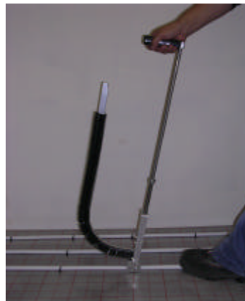
4. Alu-Setzstock entsprechend der Bilddarstellung auf dem Heizrohr positionieren. Nach Aufsetzen der Rohrführung im Setzstockfuß auf das Heizrohr (Bild 5), wird der Rohrhalter durch Druck auf den Handgriff in der Dämmung verankert.
